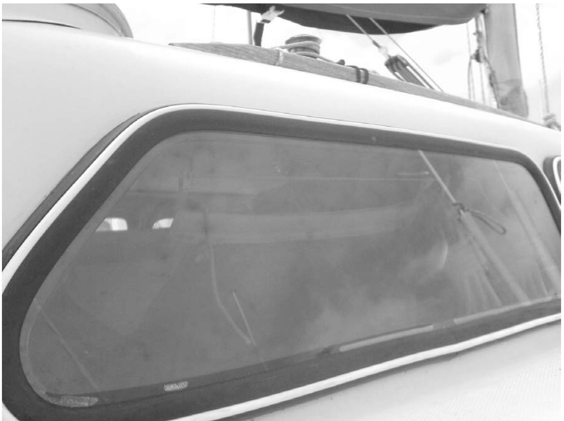
Nytt fönster med utanpåliggande ruta, monterat och klart
